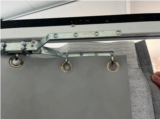
Replier le tissu et accrocher le dernier crochet à l'intérieur du cintre de recouvrement.
