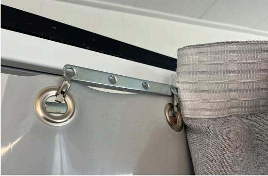
Accrocher le crochet de l'étrier de recouvrement par le haut dans la perforation
